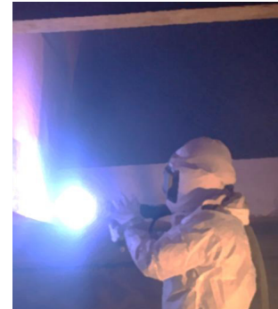
Spruzzatura zinco su tondini del c.a. ammalorato
